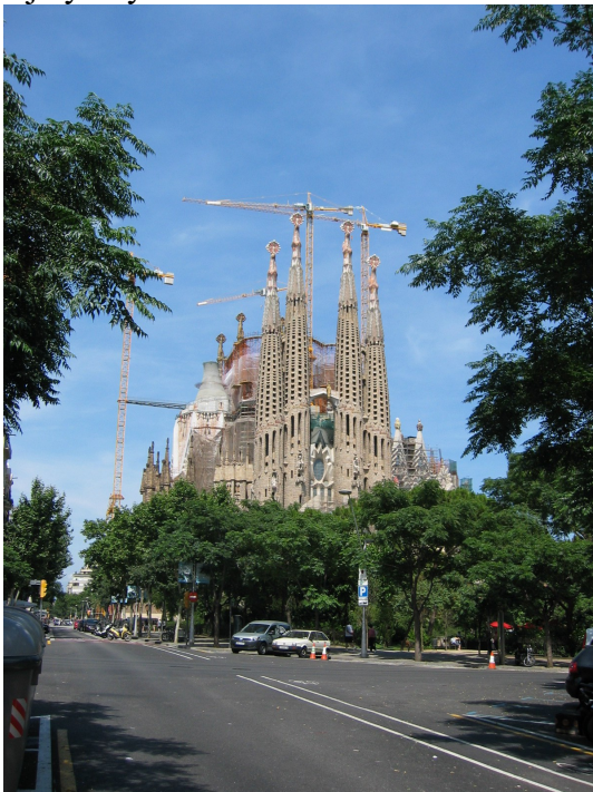
Zdj.5. Dźwigi do wznoszeniu wież bazyliki
