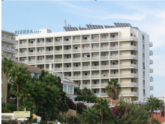
Zdj.11. Kolektory wodne –Benalmadena, SP
