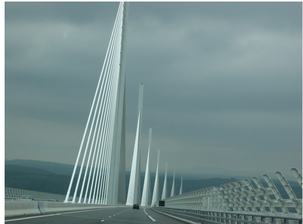
Zdj.4. Wiadukt w Millau, Francja
